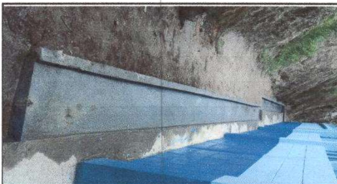
Foto 4: Cunetas finalizadas en su totalidad. Cantidad 36 metros.
